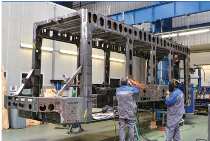
Hier sprühen die Funken: Ein Kopfteil im Rohbau erhält den letzten Feinschliff.
