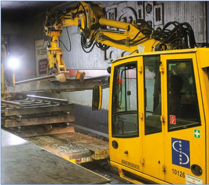
Der Bauverlauf in Bildern: Ein Bagger hebt die alten Schienen und Schwellen aus dem Gleisbett. Riesige Luftschläuche transportieren die Abluft übers Zwischengeschoss an die Oberfläche. Durch einen Schacht werden Materialien ins Freie befördert.
