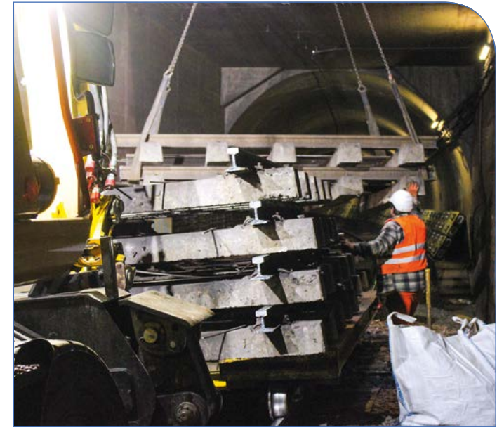
Der Bauverlauf in Bildern: Ein Bagger hebt die alten Schienen und Schwellen aus dem Gleisbett. Riesige Luftschläuche transportieren die Abluft übers Zwischengeschoss an die Oberfläche. Durch einen Schacht werden Materialien ins Freie befördert.
