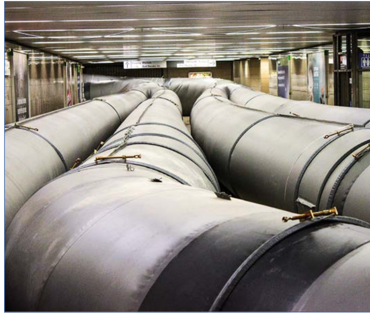
Der Bauverlauf in Bildern: Ein Bagger hebt die alten Schienen und Schwellen aus dem Gleisbett. Riesige Luftschläuche transportieren die Abluft übers Zwischengeschoss an die Oberfläche. Durch einen Schacht werden Materialien ins Freie befördert.
