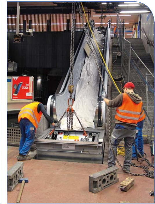
Ungewöhnlicher Anblick: eine 20 Meter lange Rolltreppe vor ihrem Einbau im U-Bahnhof Implerstraße. Bis zu vier Wochen arbeiten Techniker am Austausch einer Anlage. Weil die Teile so massiv sind, müssen teils Bahnsteige oder sogar Bahnhöfe gesperrt werden.
