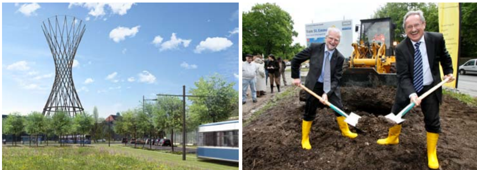
Am Effnerplatz durchquert die Trambahn das Kunstbauwerk „Mae West“ (Simulation); der Spatenstich mit MVG-Chef König und OB Ude fand an der künftigen Endhaltestelle „St. Emmeram“ statt.
