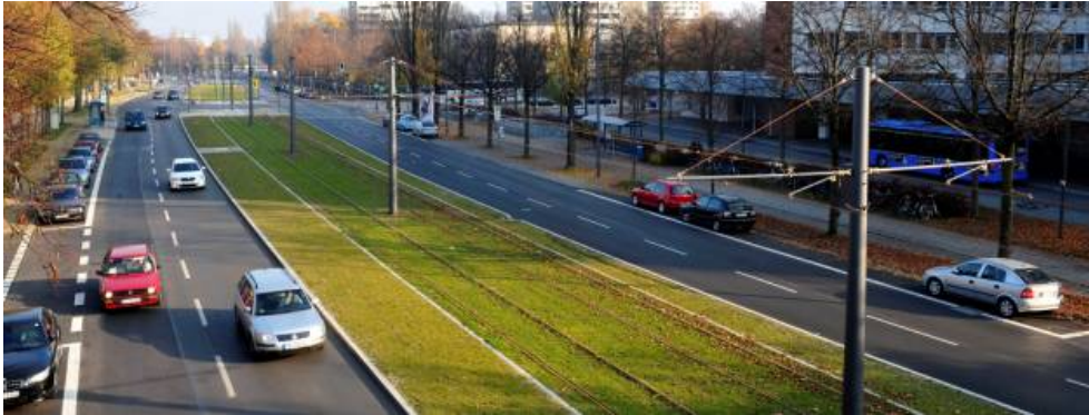
Wie ein „grünes Band“: Die Neubaustrecke in der Englischer Straße
