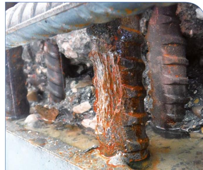
Die Grafik zeigt, wie bei der Fugensanierung vorgegangen wird. Foto Mitte: Die Baugrube verläuft an der Außenseite des unterirdischen Bauwerks. Ganz rechts der Grund für die Sanierung: Salzwasser hat die 30 Millimeter dicken Armierungseisen angegriffen.
